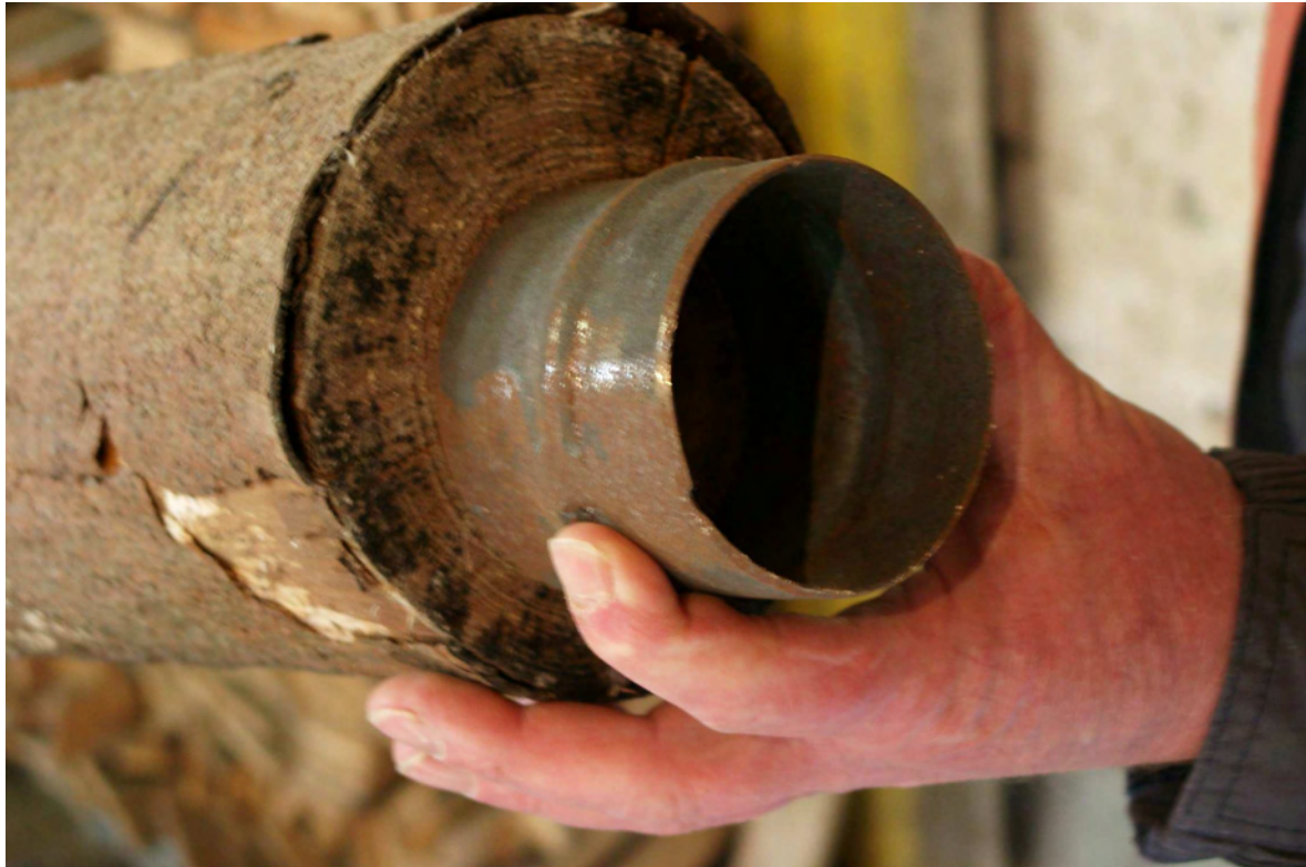
Abb. 4: Verbindung von Holzhöhlen mittels eiserner Röhrbuchsen
