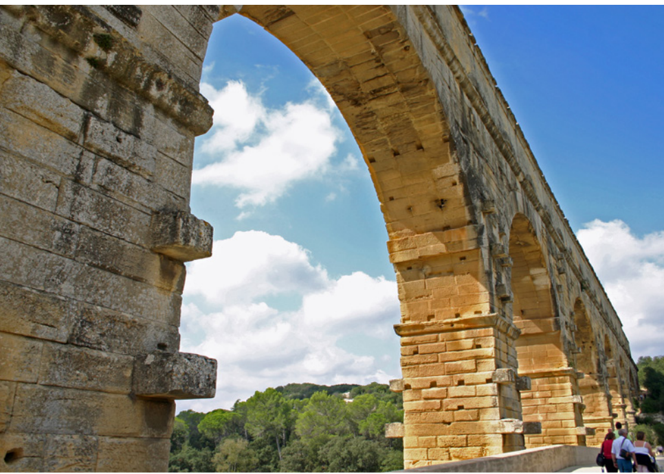
Bild 4: Anhand der Kragsteine und Balkenlöcher lassen sich Möglichkeiten für den Aufbau der Lehrbögen (Lehrgerüste) rekonstruieren.
