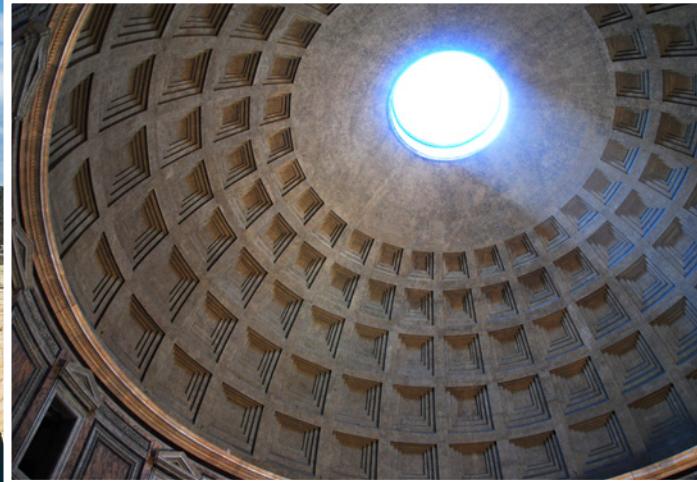
Bild 2: Die Kuppel des Pantheons in Rom war mit 43 m Spannweite seinerzeit das größte freitragende Gewölbe. In diesem Bauwerk ist der beste Beweis für die Tragfähigkeit römischen Betons (Opus caementicium) gegeben.
