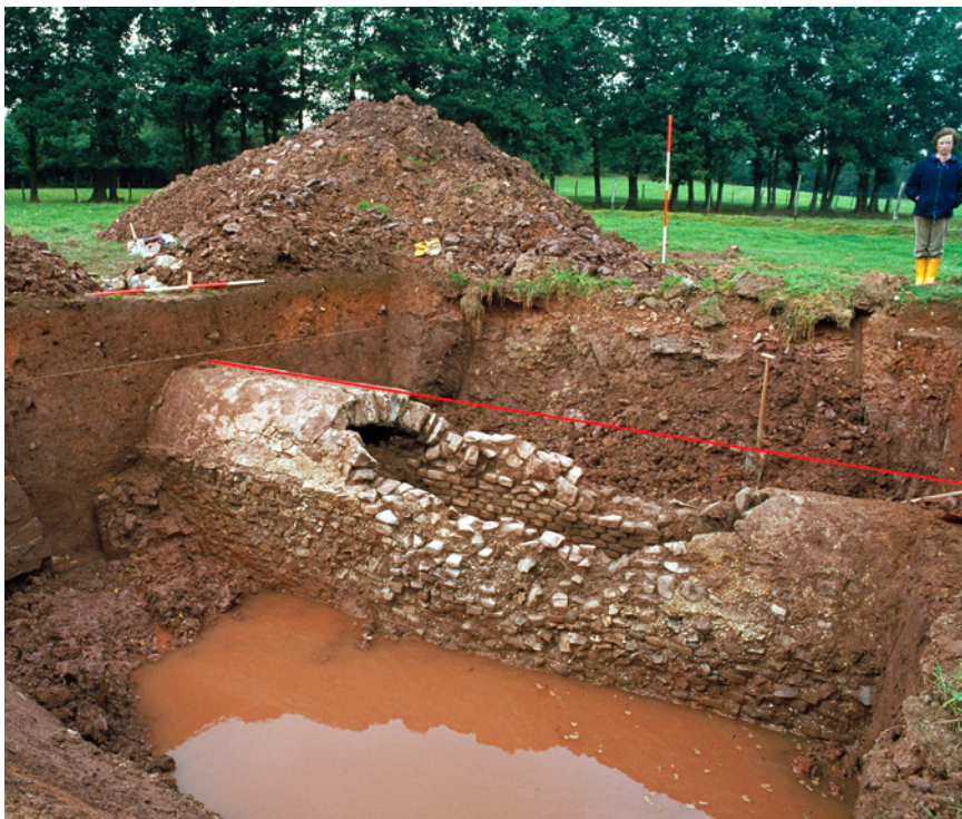
Bild 9: Beim Anschluss eines Bauloses an das folgende waren bauliche Übergänge zu schaffen. Der Befund einer Ausgrabung im Verlauf der Eifelwasserleitung bei Mechernich-Lessenich ließ schon bei der Freilegung erkennen, dass hier eine besondere Situation zu erwarten war.
