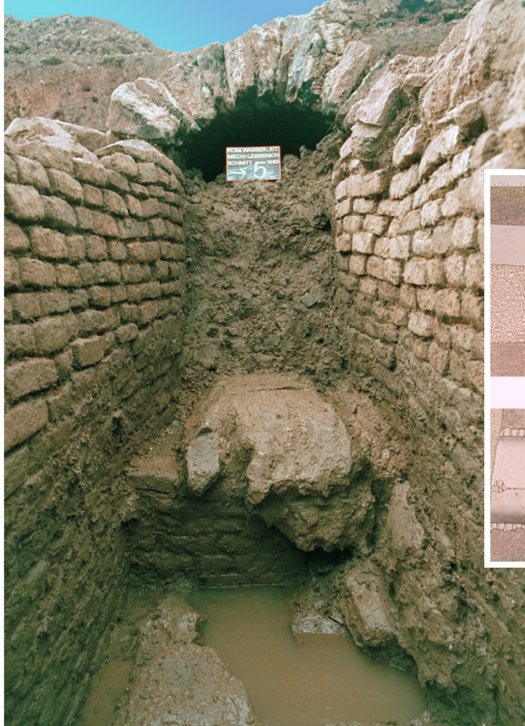
Bild 10: Die Technik der römischen Gefälleabsteckung nach der Methode des »Austafelns« bedingte zwangsläufig, mit dem Ende eines Bauloses nicht höhengleich auf den Anfang des Folgebauloses zu treffen. Ursache hierfür war die Erdkrümmung, die beim Austafeln nicht berücksichtigt wird. Um die auftretende Höhendifferenz auszugleichen, haben die römischen Baumeister eine Stufe in die Sohle der Wasserleitung eingebaut. In Mechernich-Lessenich konnte nachgewiesen werden, dass von der 35 cm hohen Sohlenstufe ca. 32 cm auf das Konto der Erdkrümmung gehen.
