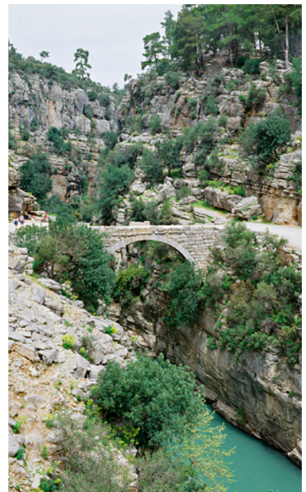
Bild 3: Die römische Brücke über den Eurymedon bei Selge (Türkei) zeugt heute noch von der Tragfähigkeit eines Halbkreisbogens, denn sie dient immer noch sogar schweren Holztransportern.
